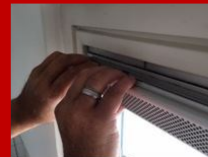
VERWIJDEREN ALUMINIUM BUITENKAP VENTILATIEROOSTER
