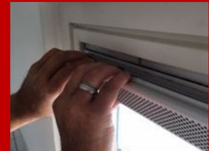
VERWIJDEREN ALUMINIUM BUITENKAP VENTILATIEROOSTER
